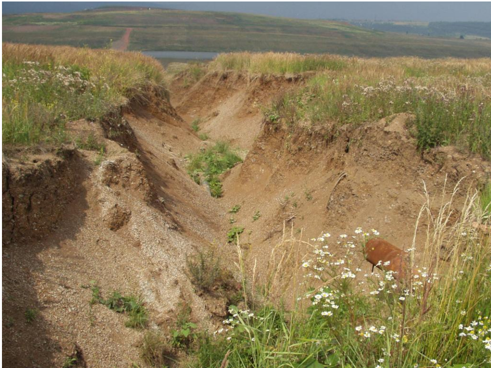
Detail erozní rýhy na vnitřní výsypce zatápěné zbytkové jámy Chabařovice
