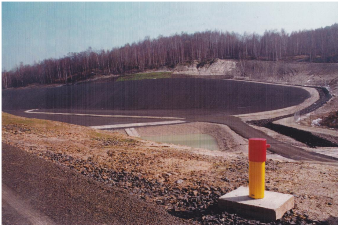
Výstavba moderní řízené skládky TKO v těsném sousedství staré nezabezpečené skládky TKO v lokalitě Štrbice na vnější Radovesické výsypce lomu Bílina (stav: 1997)
