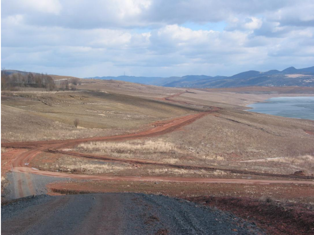
Nestabilní skryvkový svah v sz. části zatápěné zbytkové jámy Chabařovice
