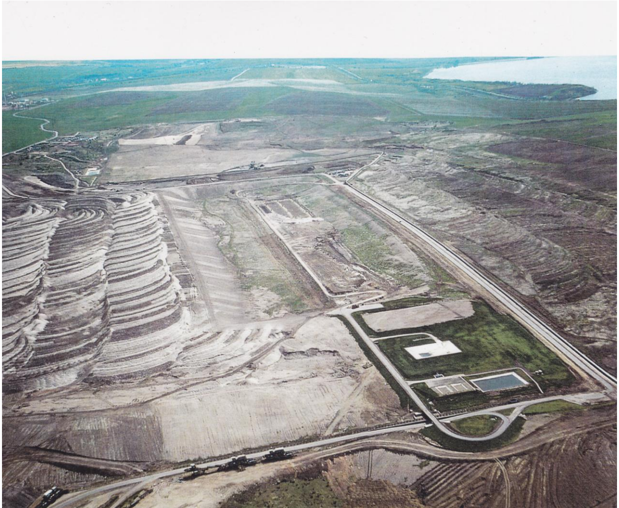
Skládka TKO a PO na vnitřní výsypce lomu Libouš (dříve Merkur), jejíž jednotlivé kazety byly připraveny v předstihu zakladačem
