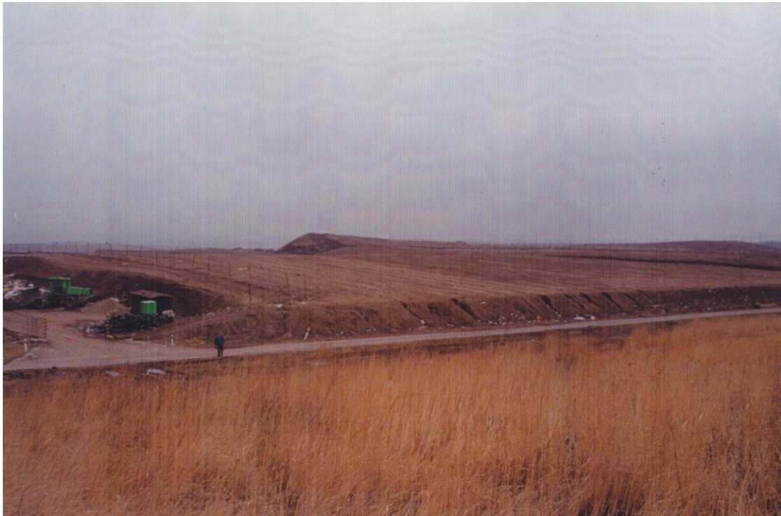
Uzavřená sekce skládky TKO města Jirkova na vnitřní výsypce Velkolomu Čs. armády pod tzv. Ervěnickým koridorem
