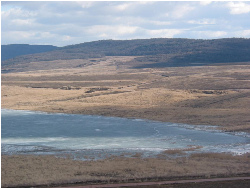
Projevy eroze na vnitřní výsypce zatápěné zbytkové jámy Chabařovice
